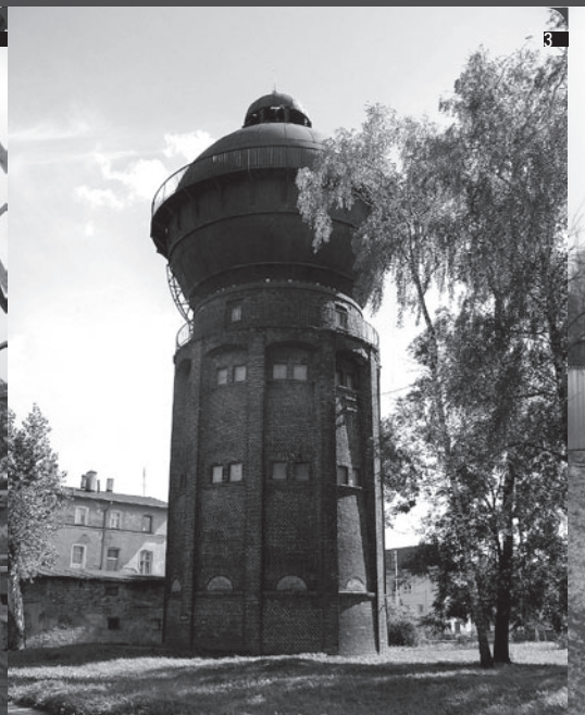
3. Kolejowa wieża wodna w Korszach (1915 r.), z kulistym zbiornikiem typu Klönne. Jedna z kilku tego typu w Polsce. Fot. Adam Płoski
