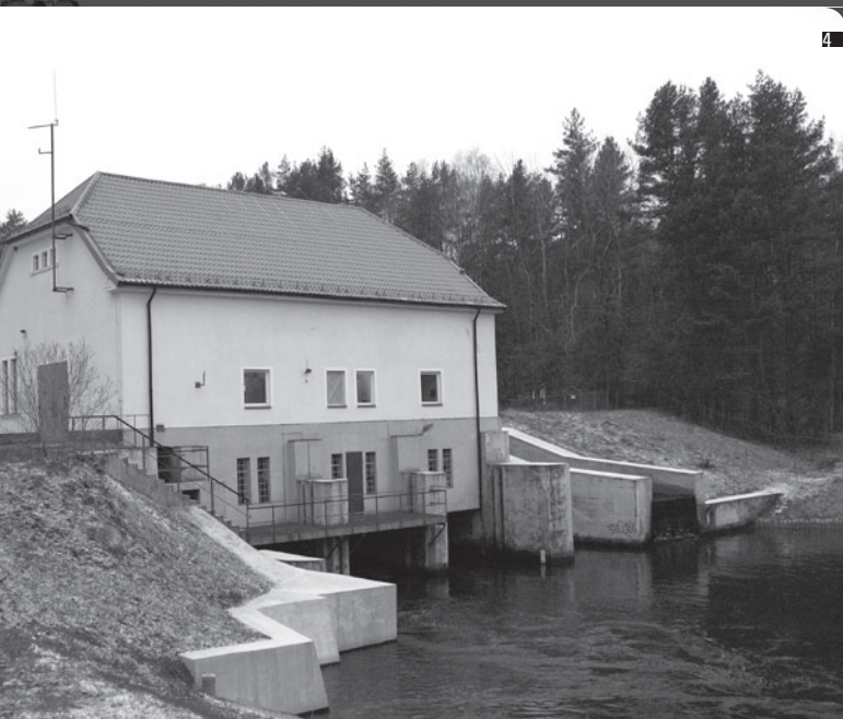
4. Budynek hydroelektrowni w Olsztynie (1907 r.) wzniesiony u zbiegu rzek Wadąg i Łyna. Fot. Adam Płoski
